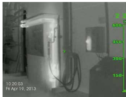
Conduite de chauffage
