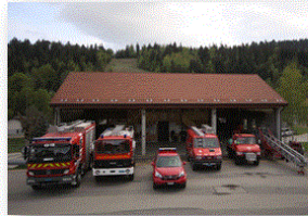
Site de St-Cergue 37 interventions
